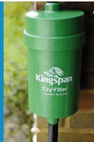
Sistema de filtración EZY Filter es un sistema de reciclaje del agua utilizada en bañeras, duchas y lavamanos para permitir un segundo uso en otras aplicaciones domesticas no potables, tanto exteriores como interiores.
